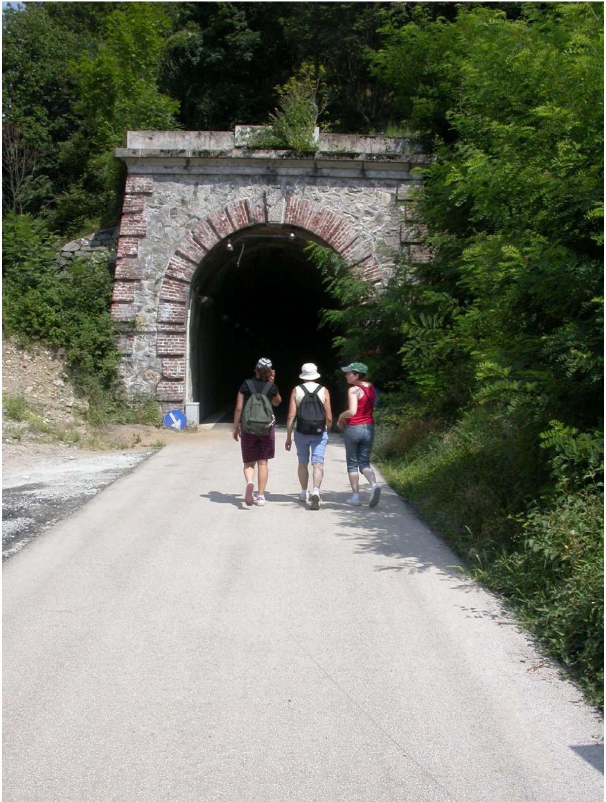
Encore un tunnel pour nos vaillantes marcheuses.
