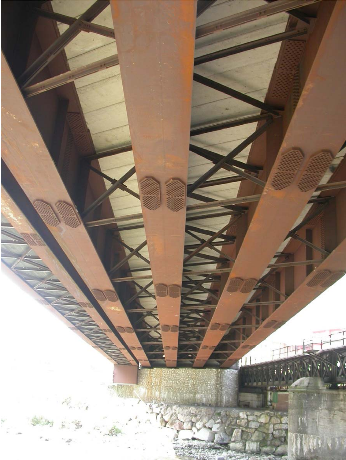
Un pont traverse le Brembo. Il s'agit de la route Zogno-San Giovanni Bianco pénétrant dans le tunnel à cet endroit-là, ce qui permet à la circulation de transit d'éviter la ville de San Pellegrino.
